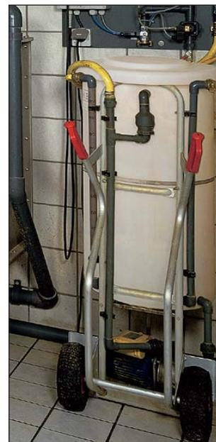
メディシステムはどんな建物でも使用でき添加物の移動式ミキシングステーションとポンプを備えています。混合添加物は常時ポンプで汲み上げられます。従って比較的安価な非水溶性の物質もなんら問題なく使用できます。薬品の投与が終了しメディサーキットが空っ
